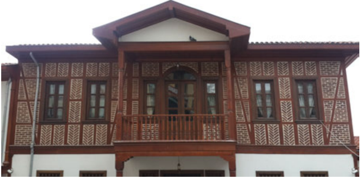
Şekil 4. Tuğla dolgulu duvar
