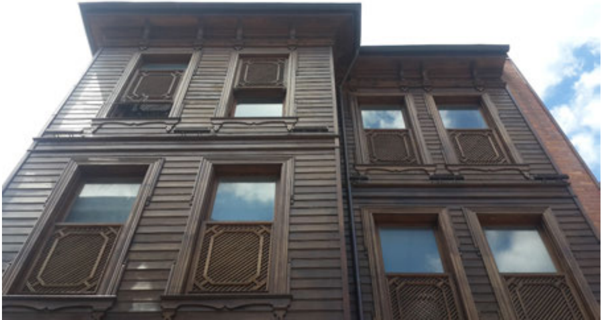
Şekil 5. Ahşap Kaplama Duvar
