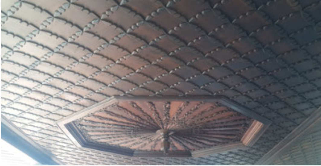
Şekil.12 Çıtalı tavan örneği
