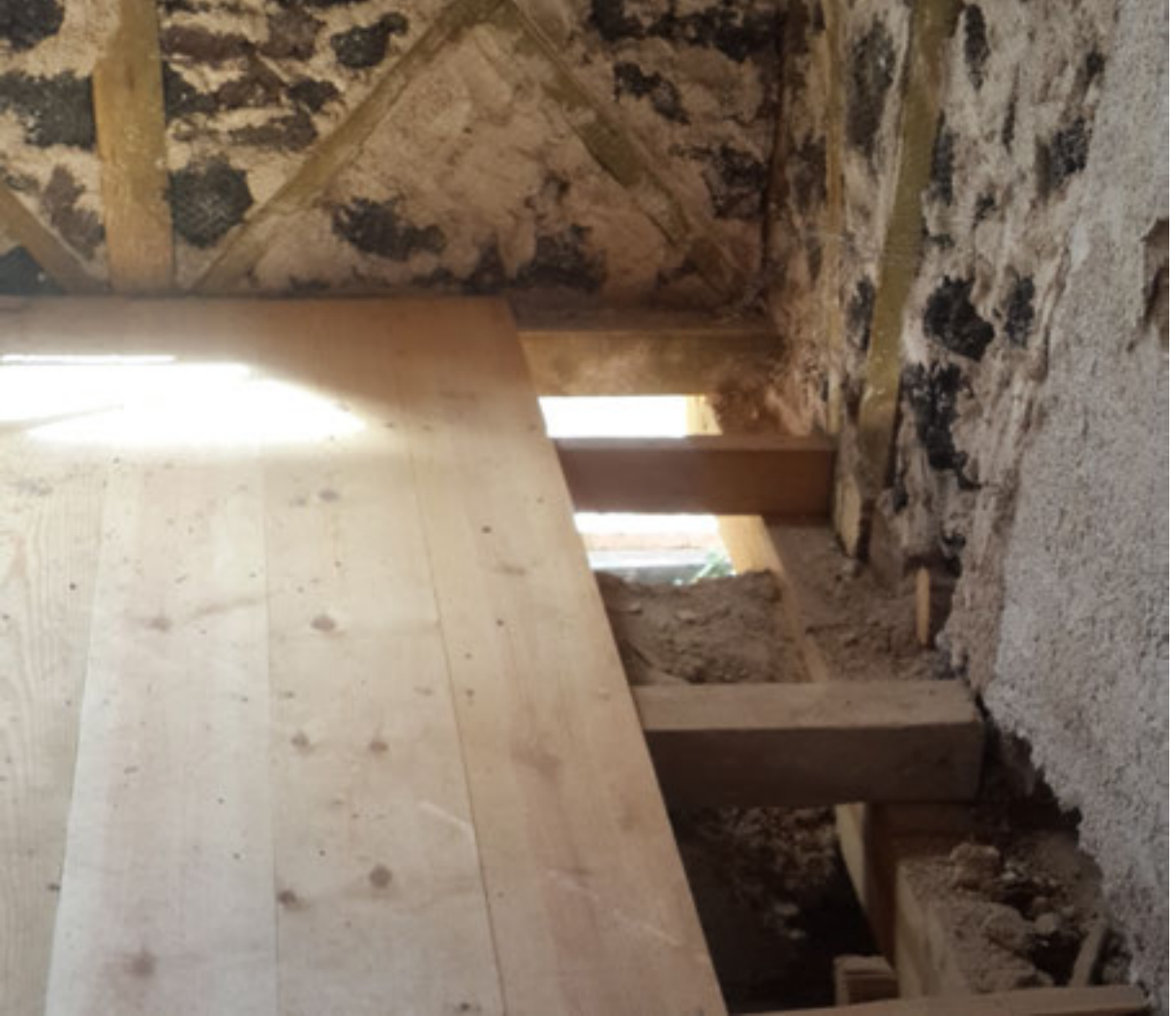
Şekil.8 Döşeme tahtasının çakılması
