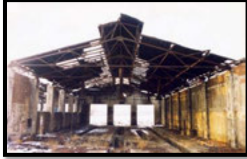
řekil 28. elik Makasları Tařıyan Betonarme Kolonlar
