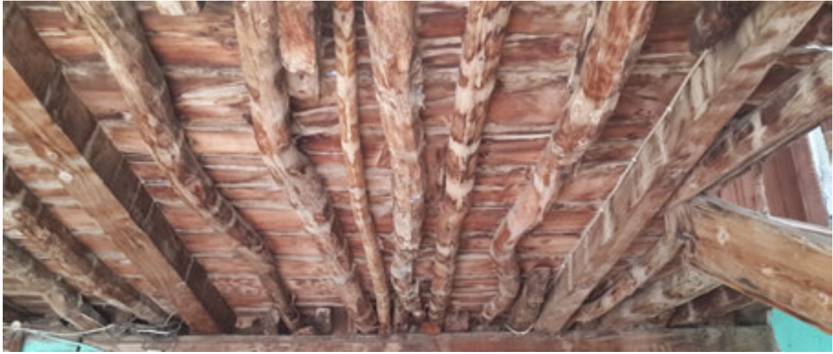
Şekil.10 Kaplamasız tavan örneği
