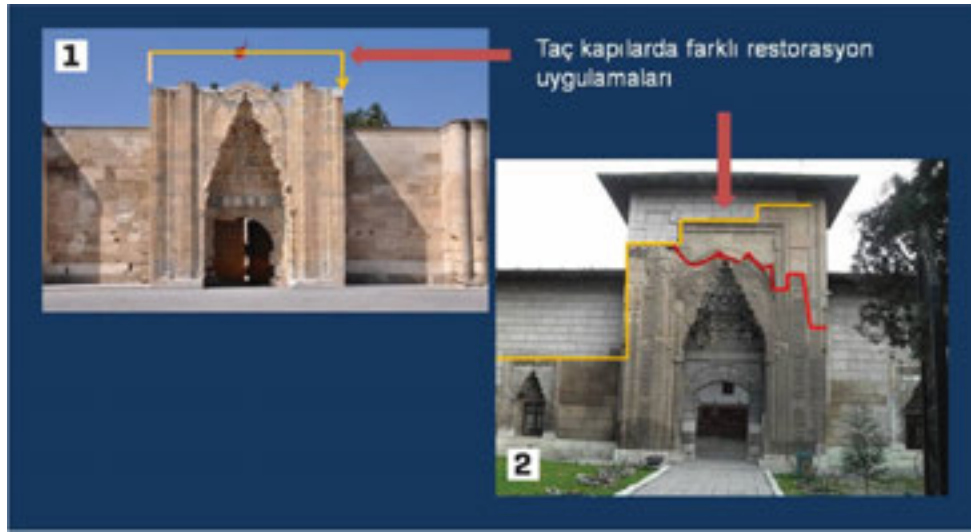
Şekil 1-2. Farklı Yıllarda Vakıflar Genel Müdürlüğü'nce Yapılan Taç Kapı Restorasyonlarında Uygulanmış Olan Teknikler.
