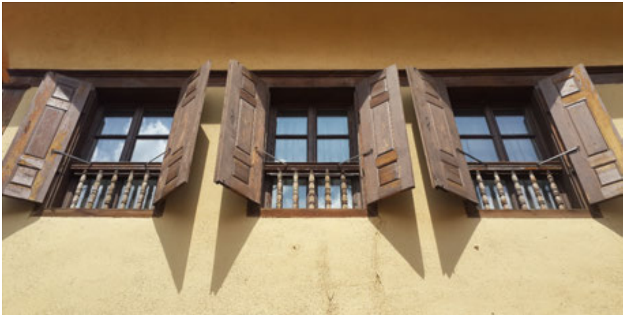
Şekil.18 Ahşap pencere kullanımı
