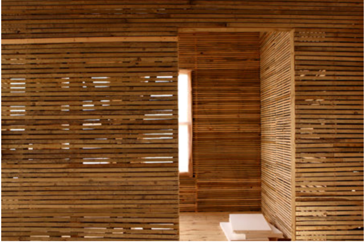
Şekil 6. Bağdadi çıta uygulaması
